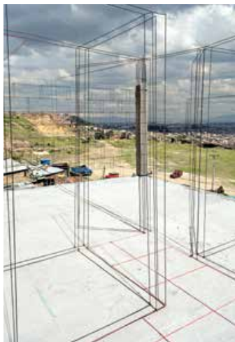
Izquierda: intervención Ciudad Bolívar, Bogotá. Instalación in-situ de hilos negros y rojos de casa proyectada, 6 x 8 x 4.5 m, detalle segundo nivel.
